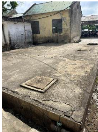
Hình 3. 14. Bể chứa nước PCCC
