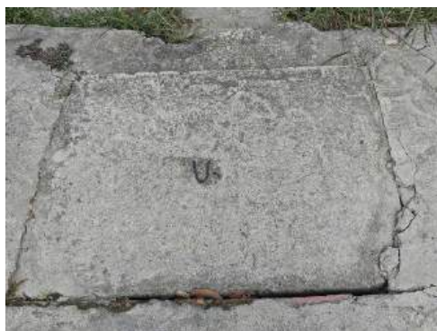
Hình 3. 5. Điểm xả nước thải trên đường Lê Ninh
